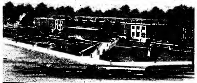
صورة (١١): منظر خارجي لمكتبة جامعية تحت سطح الأرض لاحظ كيف زرع أعلى المبنى ليتناسق مع البيئة المحيطة
